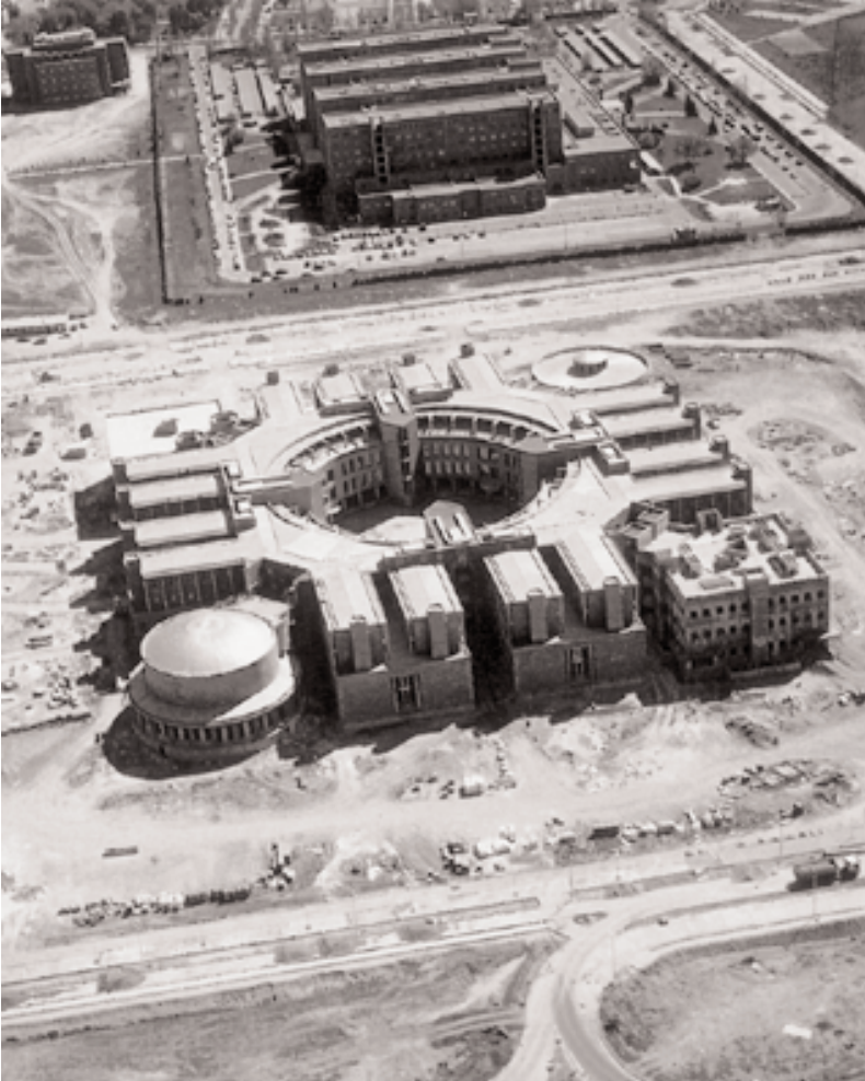
Edificio departamental politécnico. Universidad de Alcalá de Henares.
